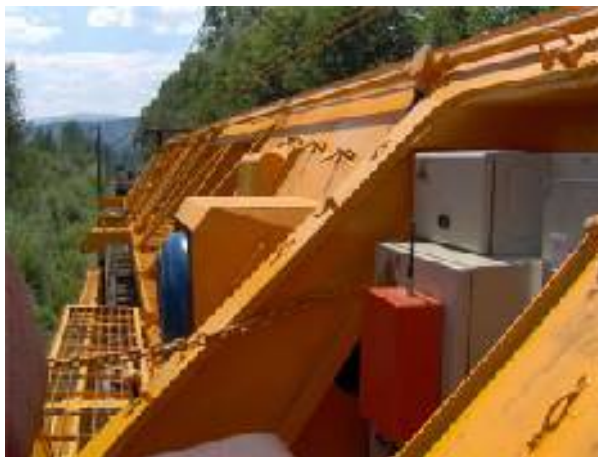
System sterowania radiowego pracą żurawia kolejowego
