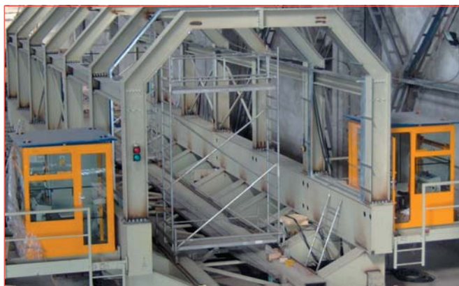
Rys. 1 Ustrój portalowy przesywnicy kolejowej Q = 150 t w fazie montażu [4]
